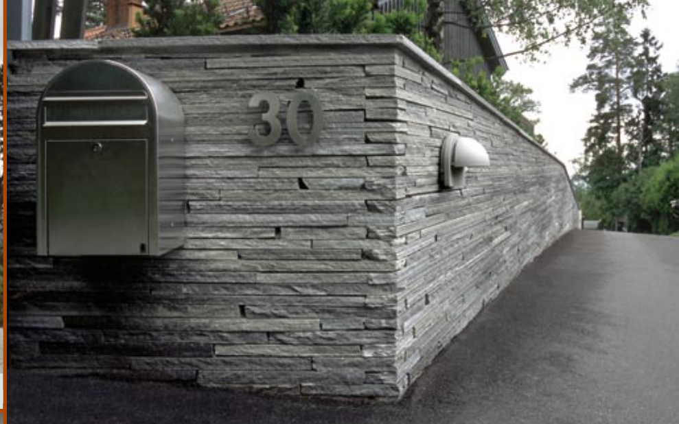
Forstøtningsmur i tørrmur 15-30 cm med hugget kant (murkapp) og avdekning i Oppdalskifer.
