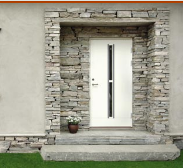
Fasade/sokkel i tørrmur 5-20 cm og massive trinn i Oppdalskifer
