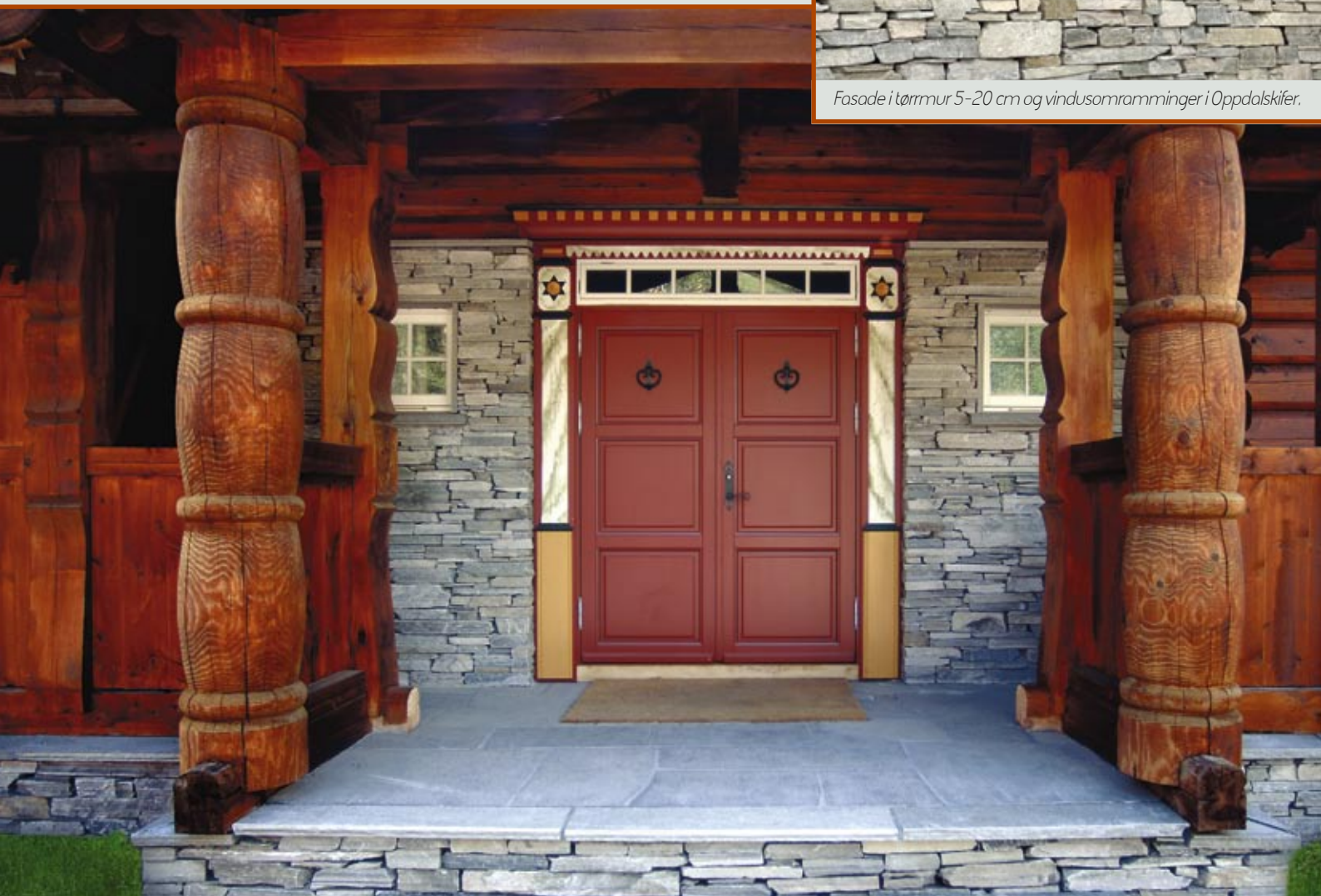
Fasade i Oppdal tørrmur 5-20 cm og repos med trappetrinn og med bruddheller i Oppdalskifer.
