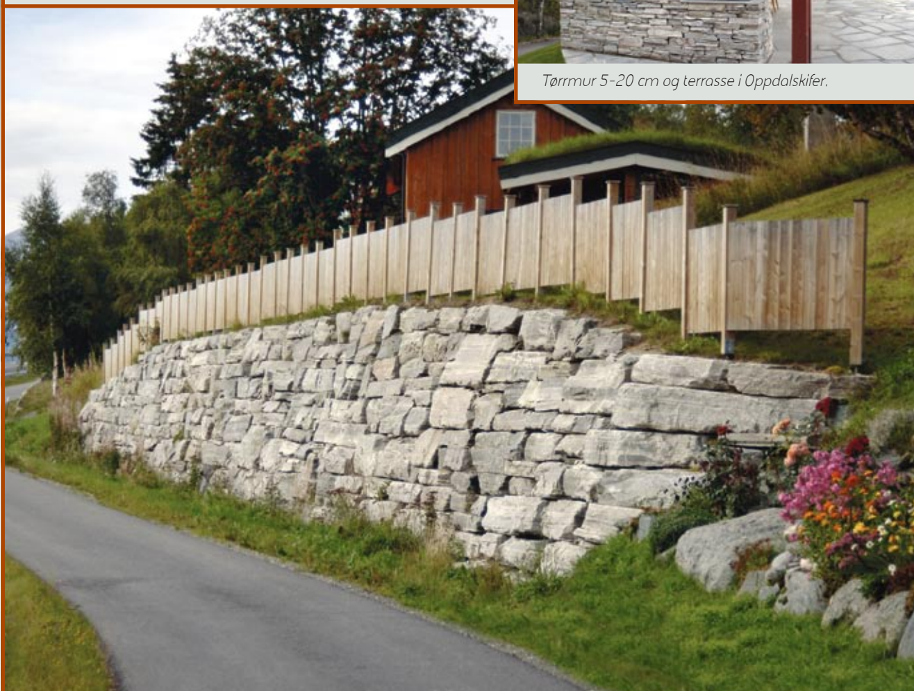
Forstøtningsmur i murblokk 60-110 cm fra Oppdal.
