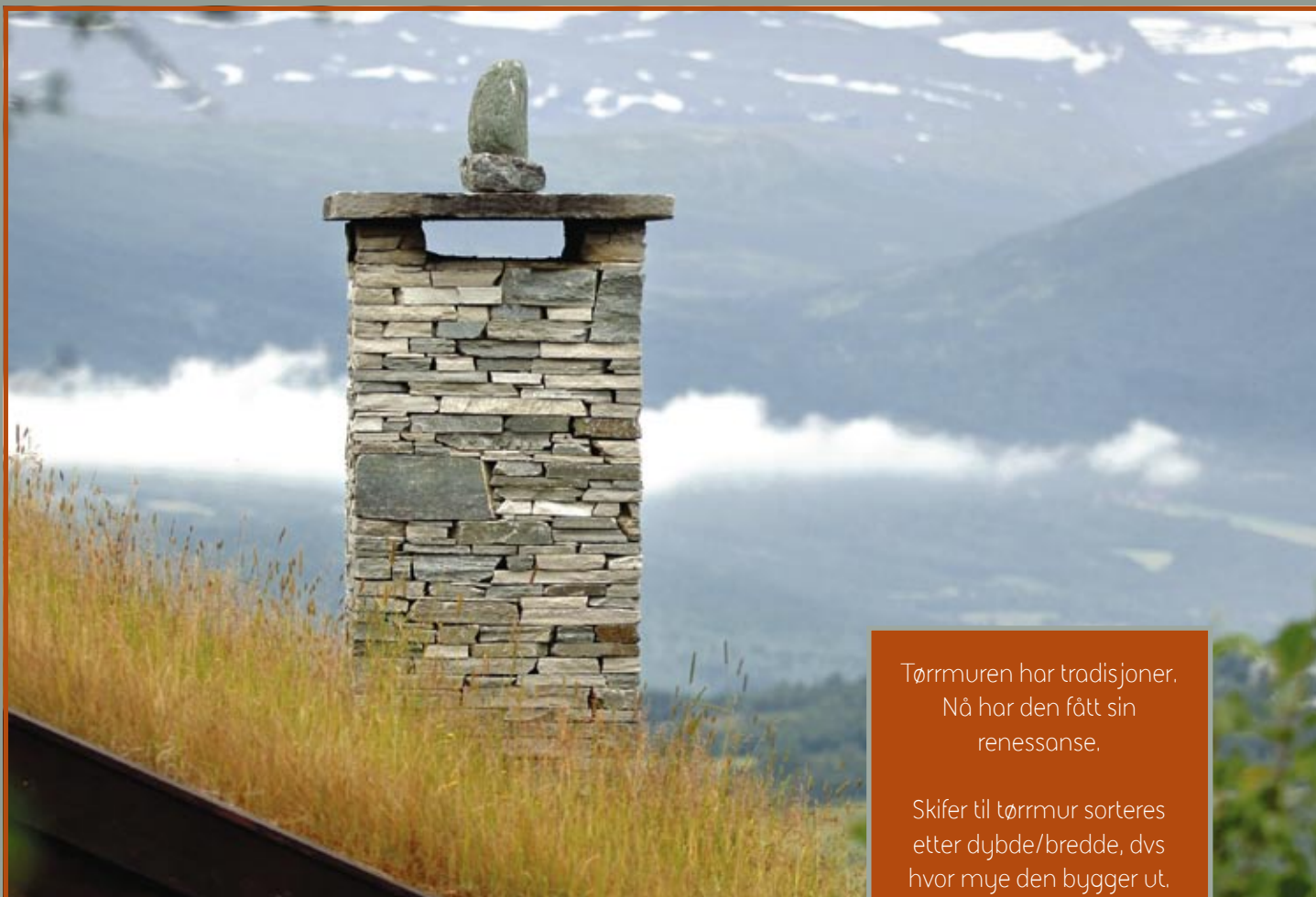
Pipe forblendet i tørrmur 5-20 cm og pipehelle i Oppdalskifer.
